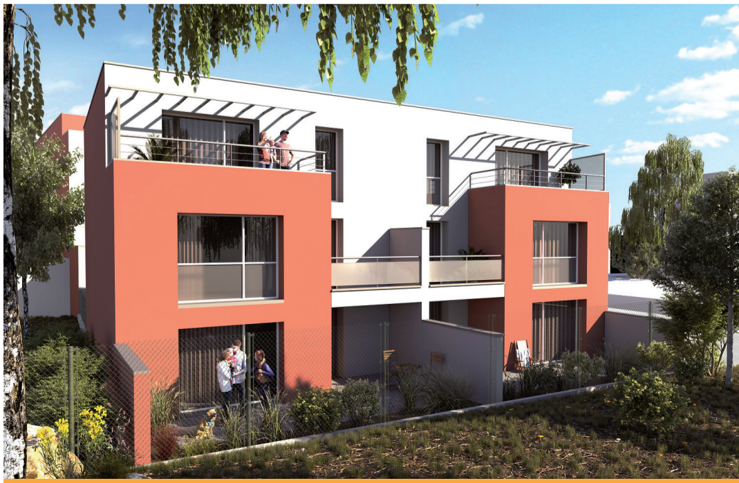
A Clermont, la résidence Indigo est en cours de construction.
