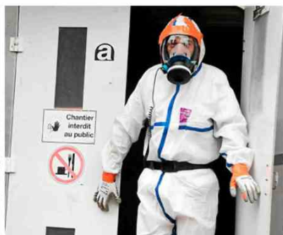
Traque. Pour chasser la moindre fibre d'amiante, des ouvriers interviennent en scaphandre.
